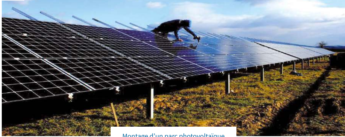
Montage d'un parc photovoltaïque
