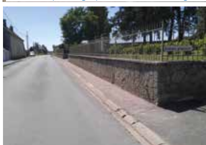
Cheminement rénové jusqu'au cimetière
