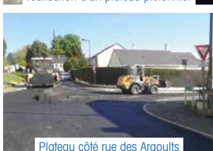
Aménagement du carrefour avec réalisation d'un plateau piétonnier
