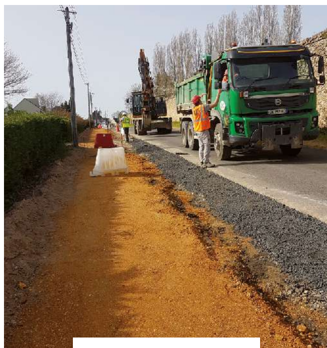
Travaux du cheminement piétonnier
