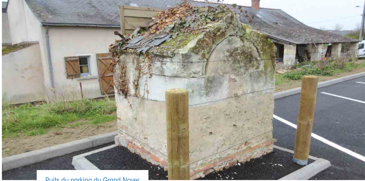
Puits du parking du Grand Noyer
