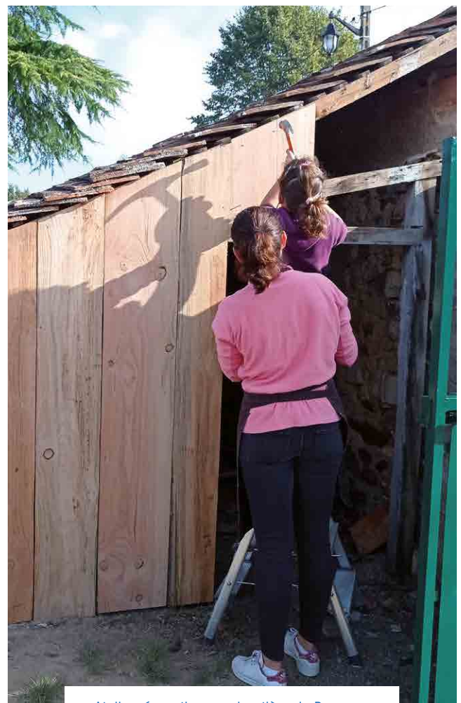
Atelier réparation au cimetière de Beauvau
