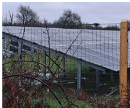
Janvier — Installation des panneaux à la centrale photovoltaïque de Beauvau
