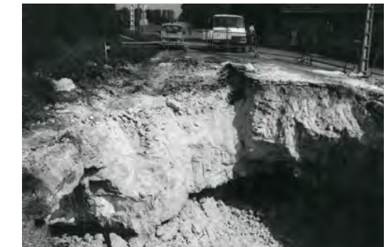
Photo 6: Excavation sous RD 59 avant comblement de sable et ciment (Source CG 49-juin 1994), Ind. 062)
