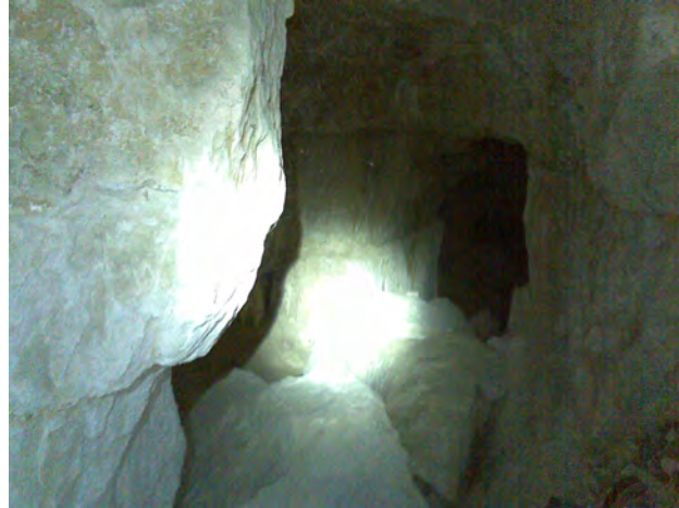
Photo 7: Ind. 015 et 016, importantes chutes de blocs
