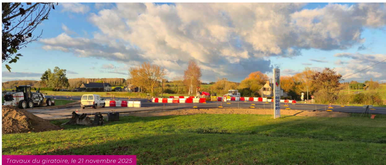
Travaux du giratoire, le 21 novembre 2025
